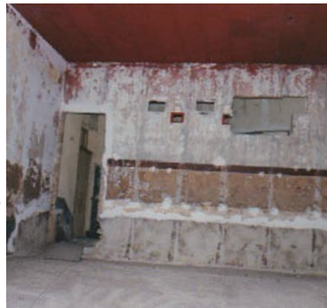
Ouverture du nouvel accès à la cabine depuis la salle
