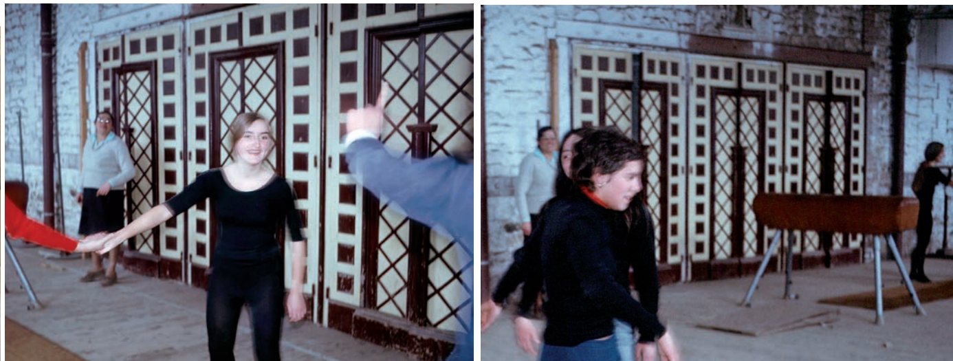
Sur ces photographies prises en 1975, on distingue en arrière-plan les anciennes portes d'entrée et de sortie de la salle de cinéma. Les portes sont restées en place jusqu'aux années 1980, bien que derrière un mur avait été reconstruit.
