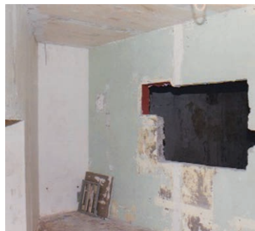
Percement de la nouvelle fenêtre de la cabine vers la salle
