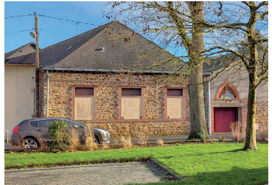
Le bâtiment du «Grand patronage» construit en 1913. Les trois grandes fenêtres ont été murées lorsque la salle de cinéma a été aménagée. L'entrée se faisait par le côté droit.
